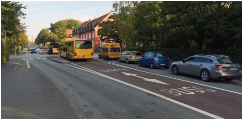
Figur 2.2: Eksempel på reversibelt midtstilt bussfelt i Lund. Kilde: Guidelines för attraktiv kollektivtrafikk, hentet fra Statens vegvesen 2016a.
